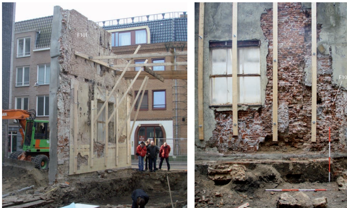
Afb. 11 Boven: de nog overeindstaande kloostermuur (F101) gezien richting het westen. Rechts: zijaanzicht van de kloostermuur (F101) gezien richting het noorden. Zichtbaar is hoe de muur zich onder straatniveau verbreed.
