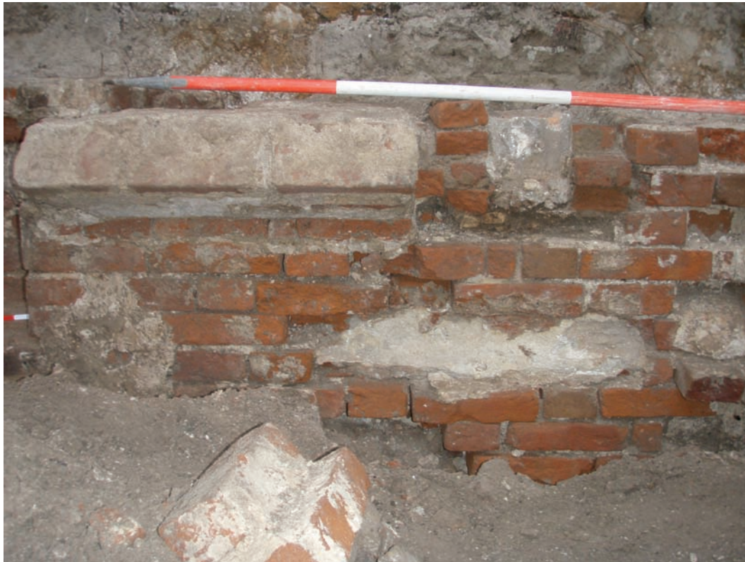
Bijlage 3. Detailfoto van het muurwerk F27b met daarin twee aanzetten van een gewelf
